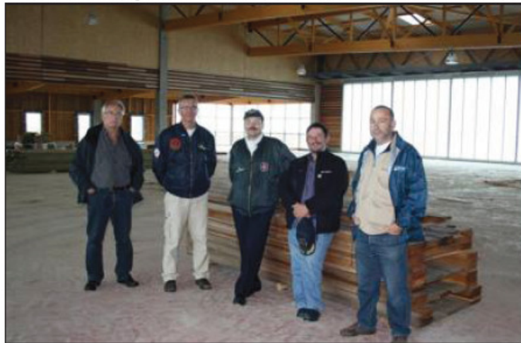
Régulièrement, les membres du club viennent constater et apprécier l'évolution des travaux. Photo RL
